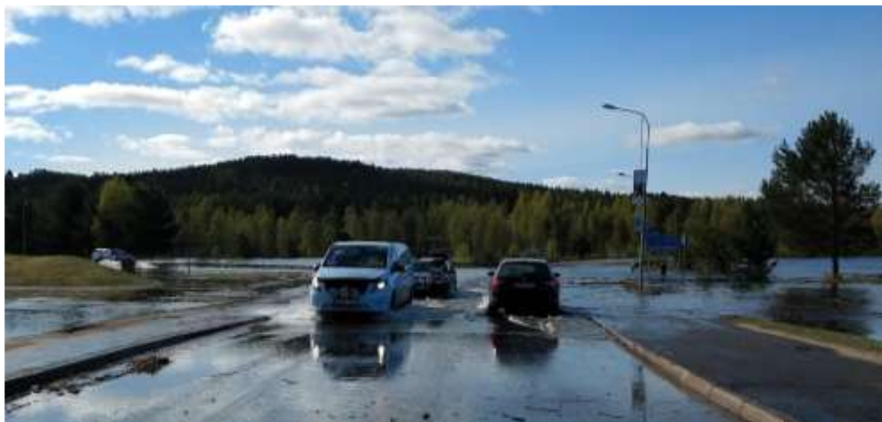
Bild 2: Översvämningssdrabbad vägkorsning på centralorten, Bränna
